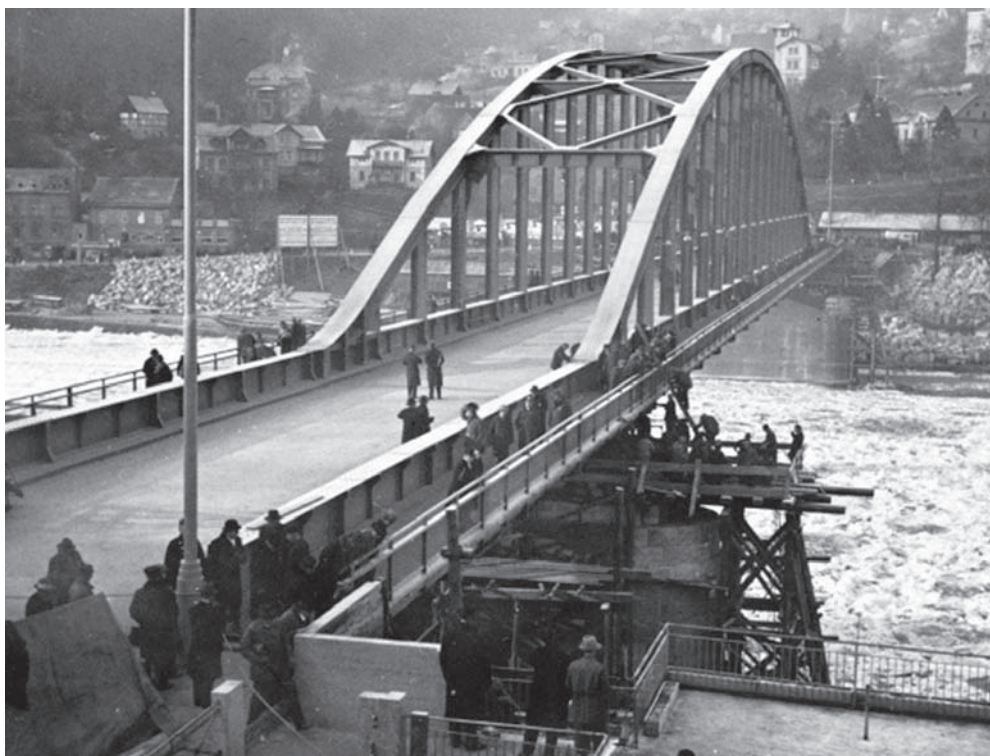
Uložení mostu Dr. Miroslava Tyrše na pilíře 9. prosince 1933. Téhož dne odpoledne byl most slavnostně otevřen.
